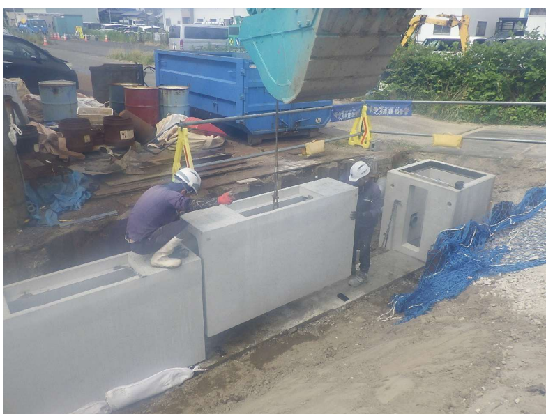
自由勾配側溝(300×1000) 布設状況
