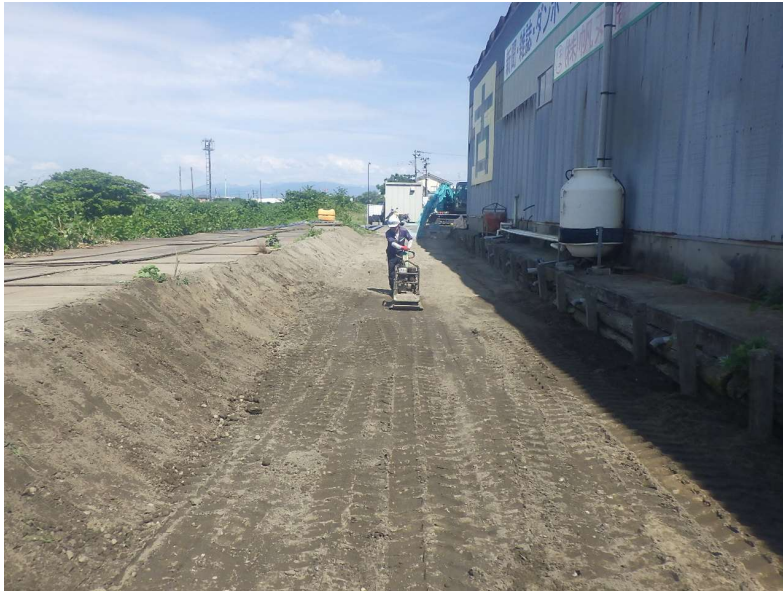
路盤工 路体転圧状況
