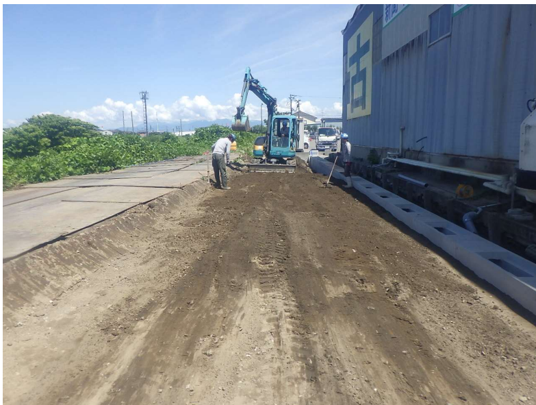
路床敷均し状況
