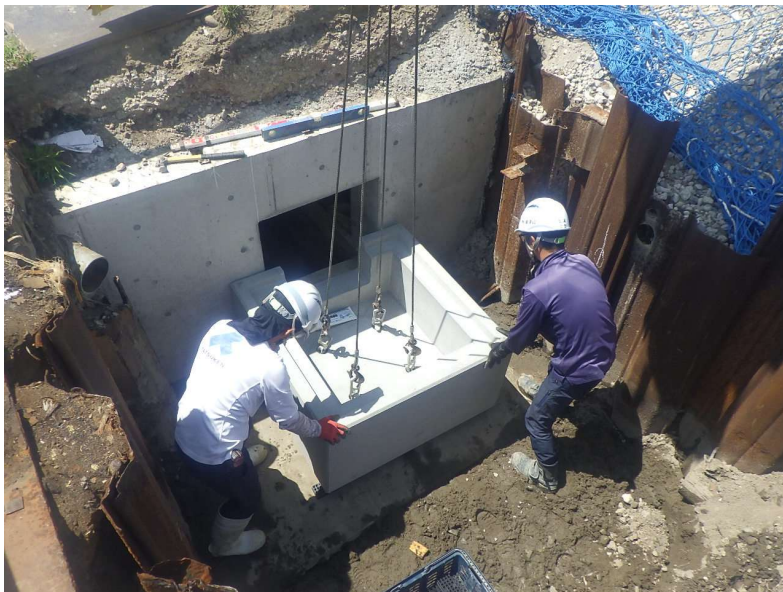
集水桝工 (800 × 800 × 1650) 集水桝据付け状況
