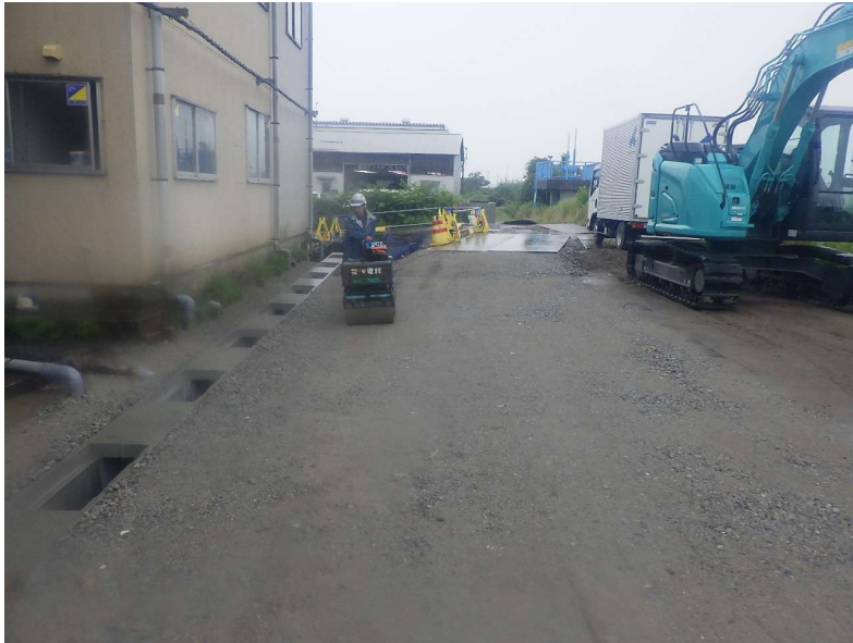
路盤転圧状況
