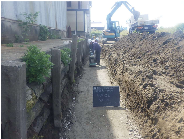
基礎砕石転圧状況
