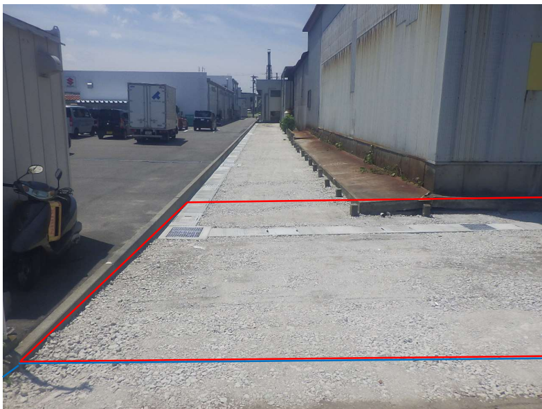
竣 工 撮影方向(北側→南側) →河川保全区域 →河川区域
