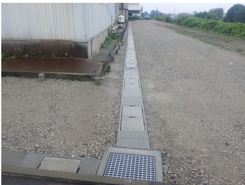
自由勾配側溝(300×700～1000) 布設完了
