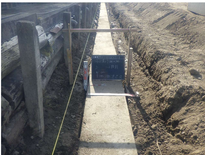
基礎コンクリート出来形検測 W=600mm T=100mm
