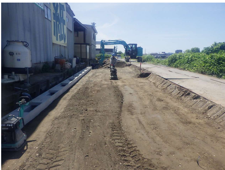
路床転圧状況
