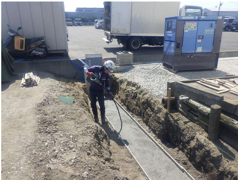
基礎コンクリート 打設状況
