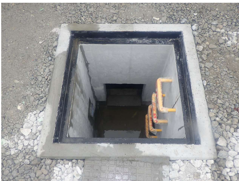
集水桝据付け完了
