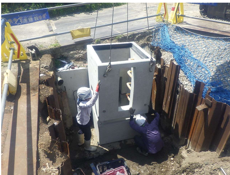
集水桝据付け状況
