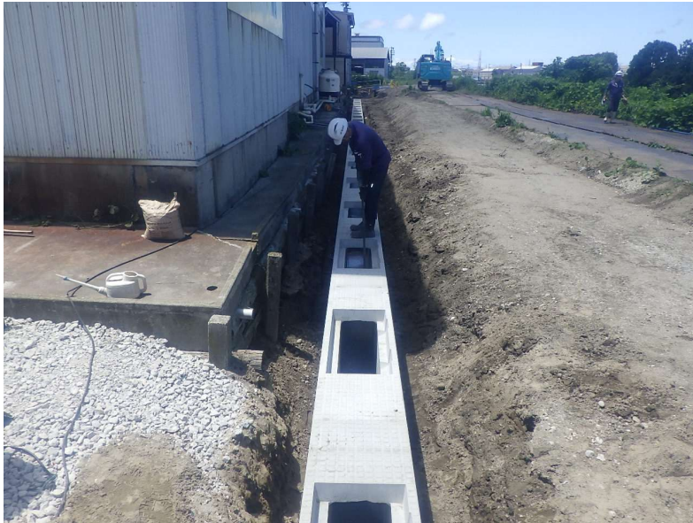
底部コンクリート 打設状況
