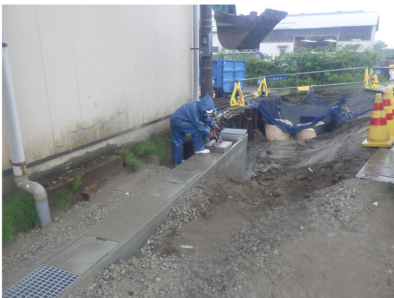
コンクリート蓋掛け状況
