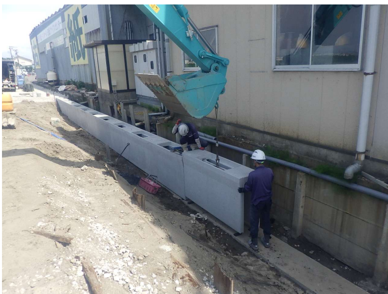
自由勾配側溝(300×900) 布設状況
