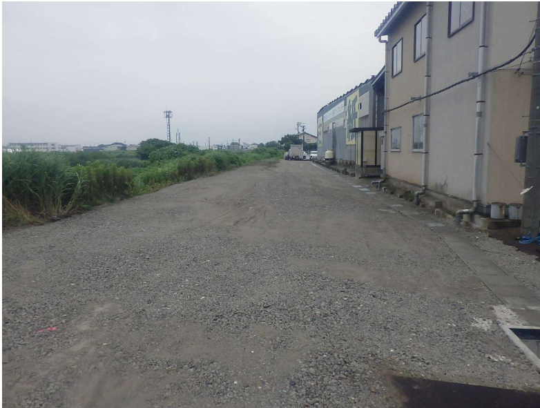
路盤転圧完了
