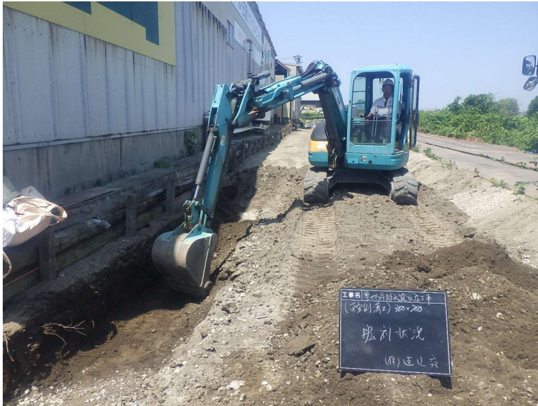
自由勾配側溝工 (300 × 700 ~ 1000) 掘削状況
