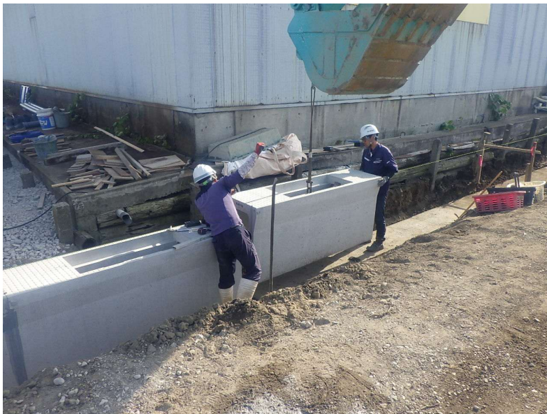
自由勾配側溝(300×700) 布設状況
