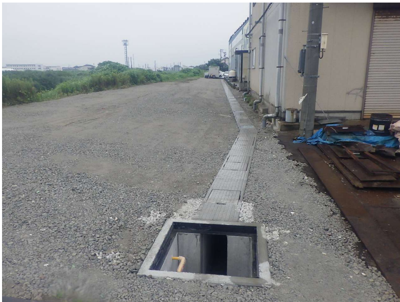
自由勾配側溝(300×700～1000) 布設完了
