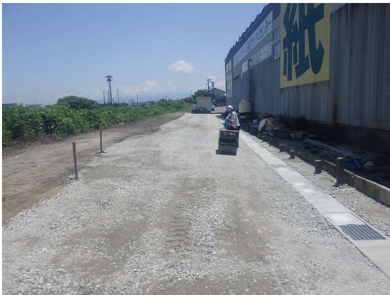
路盤転圧状況
