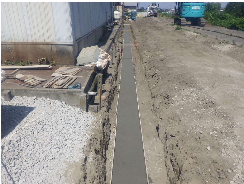
基礎コンクリート 打設完了
