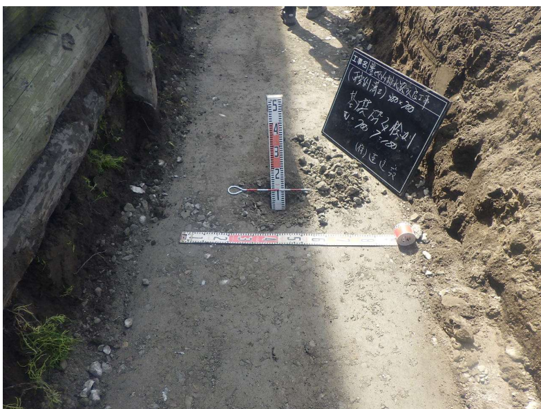
基礎砕石出来形検測 W = 700mm T = 100mm
