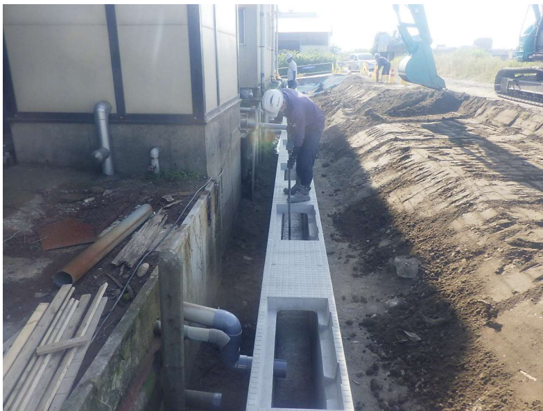
底部コンクリート 打設状況
