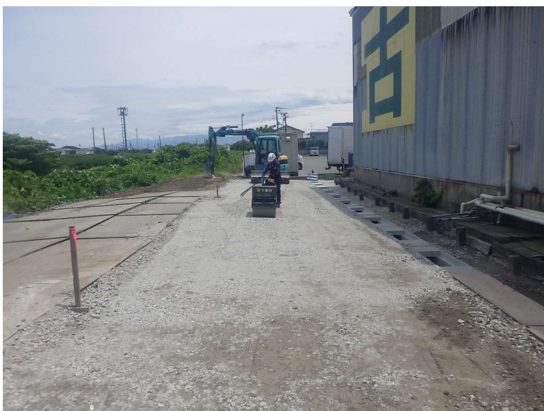
路盤転圧状況
