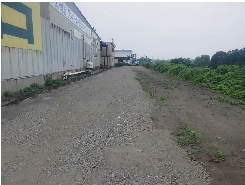
路盤転圧完了
