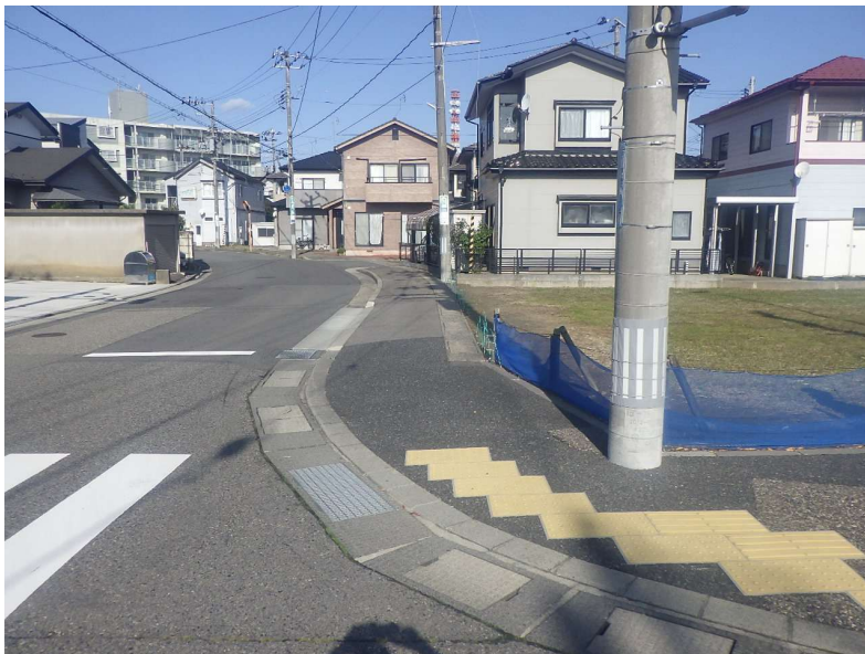
網川原楚川線1号 着手前1
