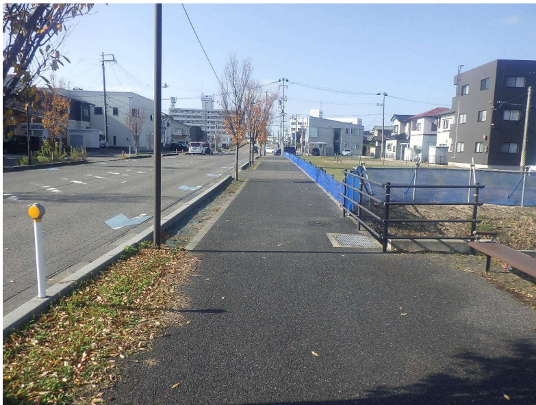
新潟市道 南4-122号線 着手前1
